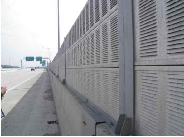
방음벽 상태 양호
