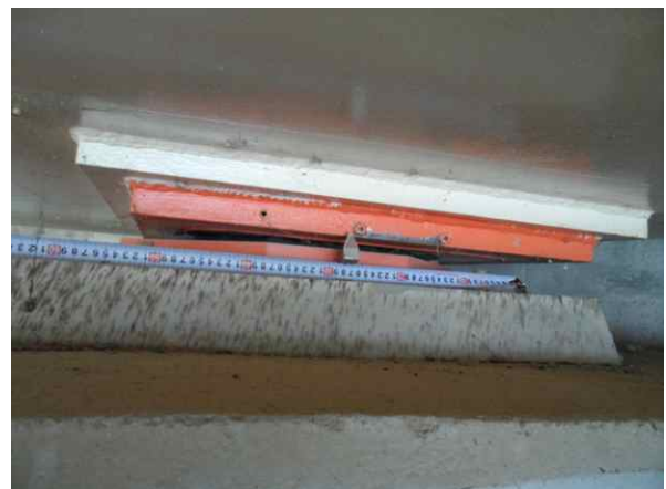
교량 받침 가동량 측정
