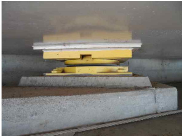
A1-Sh2 상태 양호
