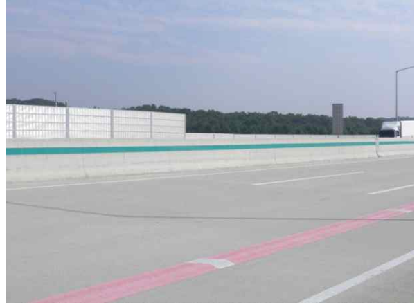
중앙분리대 상태 양호
